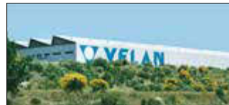
Lisbon, Portugal Velan Válvulas Industriais, Lda.
